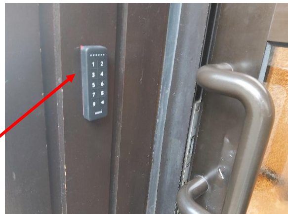
Zahlenfeld an der Außentür zur Halle
